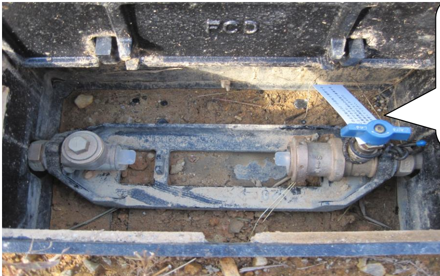
写真2 正しいユニットハンドル取付け状況
