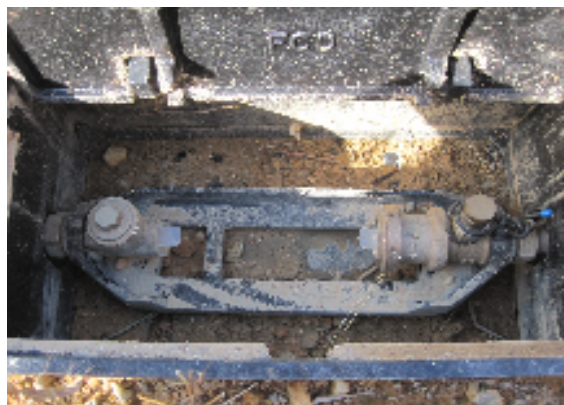
写真1 以前の取付け状況写真
