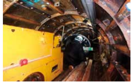
三ヶ峯幹線管挿入工
