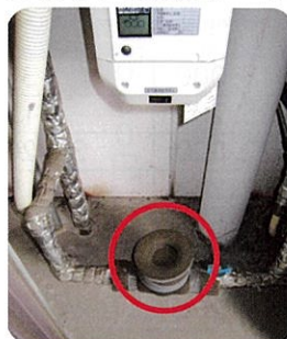
水道メータボックスの 中の水道メータ
