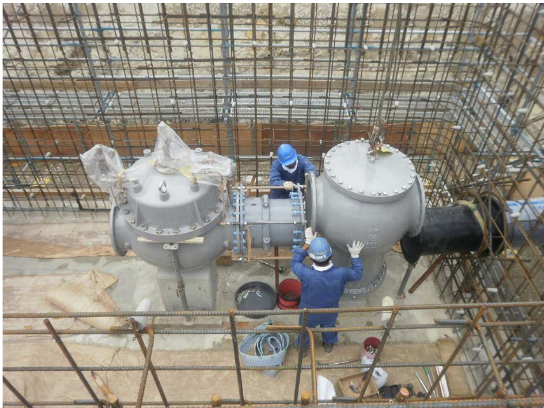
図 2-3 沓掛減圧弁設置工事
