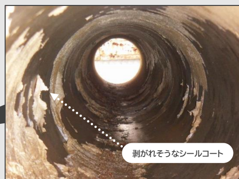
老朽管路の内面の状況
