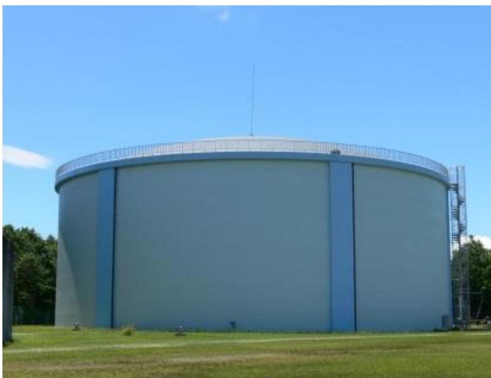
三ヶ峯配水場
