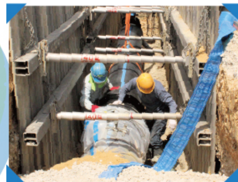
配水管を延ばす工事をして います。
