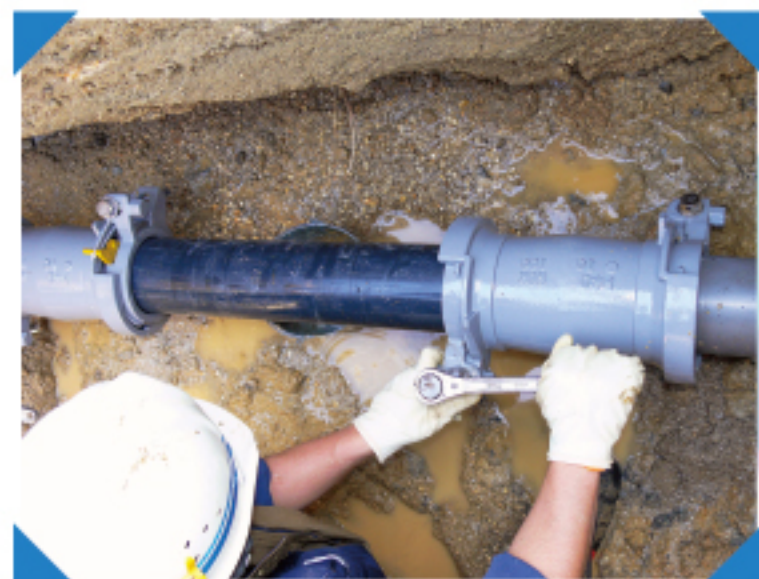
配水管の水もれを修理しています。
