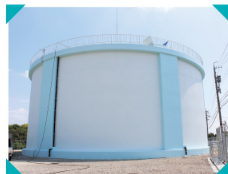
いつでも水が使えるように、 配水池を管理しています。
