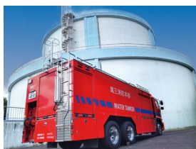
▲配水場と消防大型水槽車
