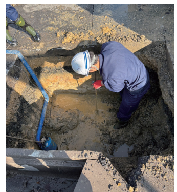
▲漏水修理の様子
