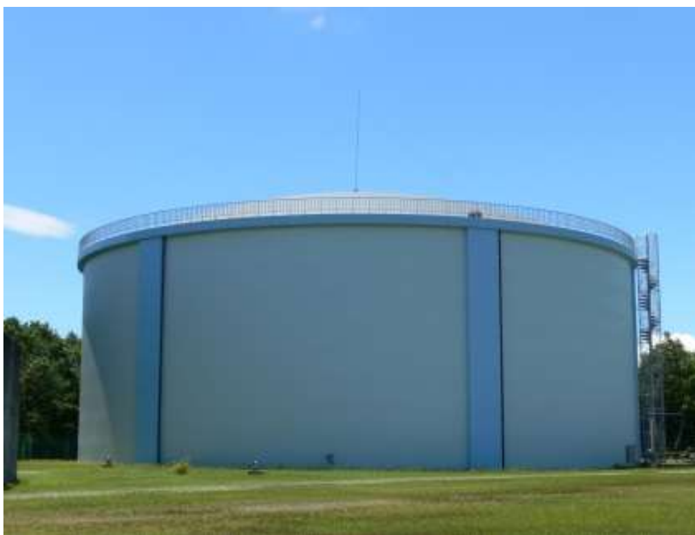
三ヶ峯配水場
